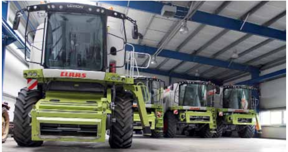
Beim Bau der Neumaschinenhalle wurde diese auch gleich mit Heizung, Strom- und Druckluftversorgung sowie Krananlage versehen. So können in Stoßzeiten hier auch Maschinen komplettiert werden.
